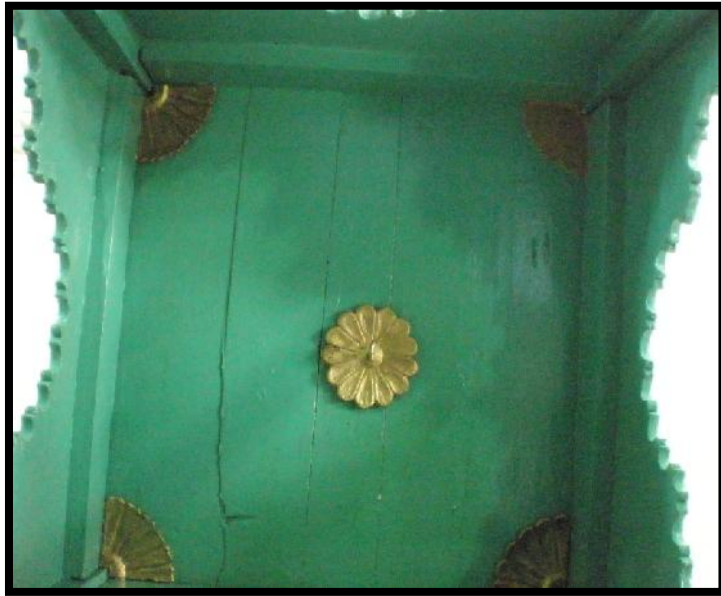
الصورة 27 : سقف جلسة الخطيب بجامع سيدي لخضر
